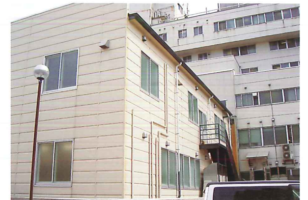
新築後の検査・リハビリ棟
