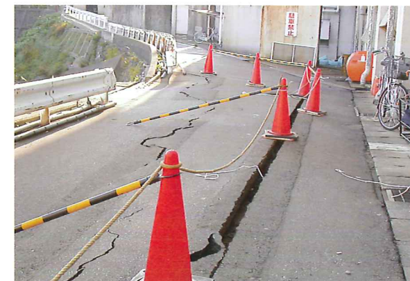
病院裏の市道
