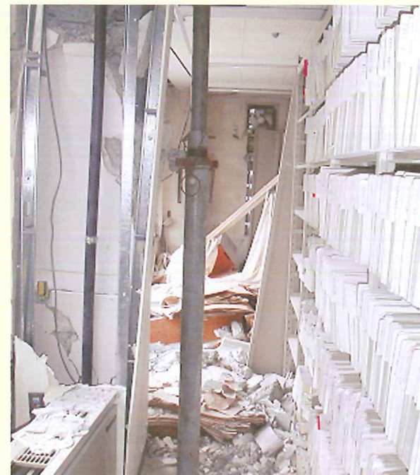
旧検査棟内部
