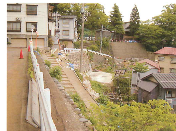
解体後の旧看護学校跡地
