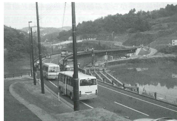
図8 開通した国道291号と撤去中の旧橋（芋川）
