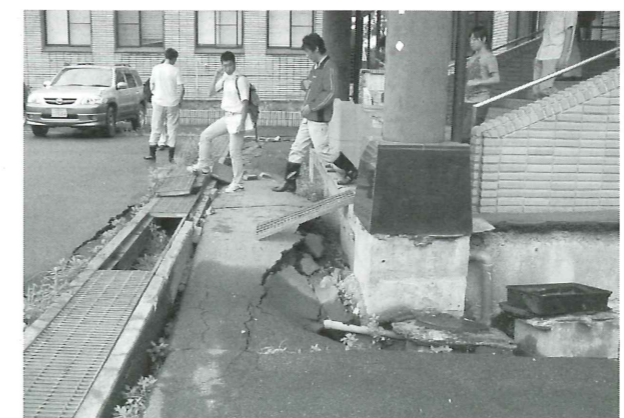
図4 旧山古志村役場の被害
