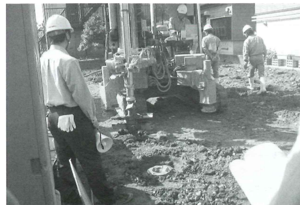
図7 深層混合処理工法の施工
