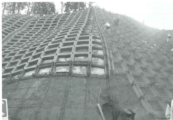
図6 西谷地区の斜面工事
