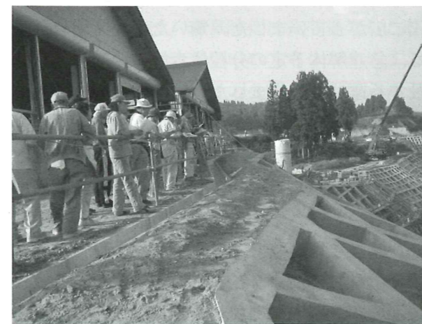
図10 榑木の地すべり対策工事と牛舎
