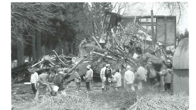
図2 川口町田麦山の住宅被害
