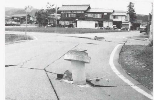
小国の中街道の電柱がすべて傾いて並び、四つ辻の信号機は倒れ、タベ崩れかかっていた集会場はいつ倒れても不思議でない程前のめりに傾いていた。道の真ん中に下水のマスが二尺程飛び出し道路面は波打つように続いた。
