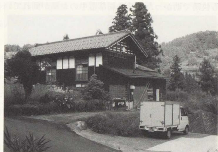
私の家は高台に有り敷地が傾き地割れが何本も建物の中に入り一階部分の柱が開き、しきり桁差しかが抜け玄関は十センチ程本屋から外れた。
